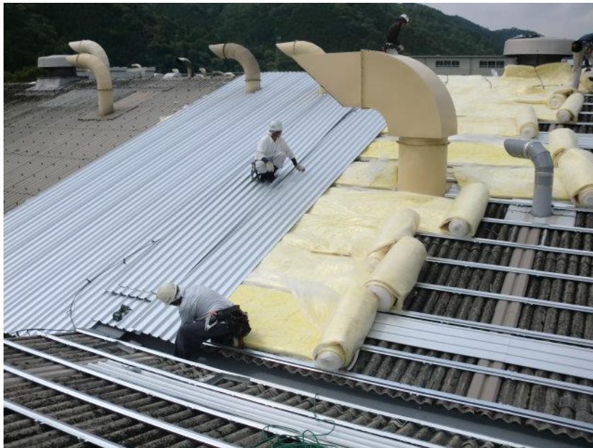
屋根断熱材敷き、 t = 50\text{mm} 、 24\text{K g} 品 施工中
